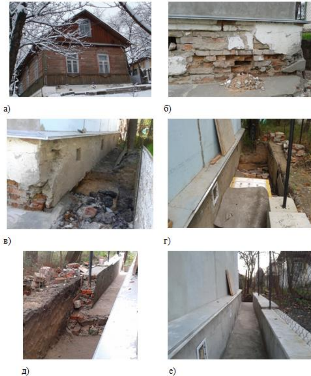
Рис. 2 – Підсилення фундаменту одноповерхового будинку по вул. 1-го Травня в м. Чернігові: а) – загальний вид будинку; б) – вид фундаменту до підсилення; в) – підсилення фундаменту; г) – влаштування монолітної плити; д) – влаштування підпірної стіни; е) – загальний вид після завершення робіт.
